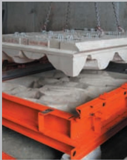
Démoulage d'une écaille Demoulding of the concrete element Entschalen des Betonelements
