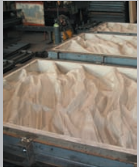
Matrices préparées au coulage du béton Formliners prepared for concreting Matrizen vorbereitet zum Betonieren
