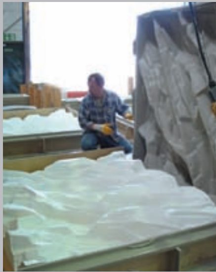
Démoulage d'une matrice du modèle Demoulding of the formliner from the master mould/pattern Entschalung der Matrice vom Modell
