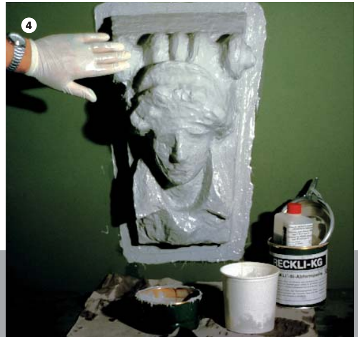
4 Si-Spachtelung mit der Hand verschlichten Smooth Si Paste by hand Egalisation à la main
