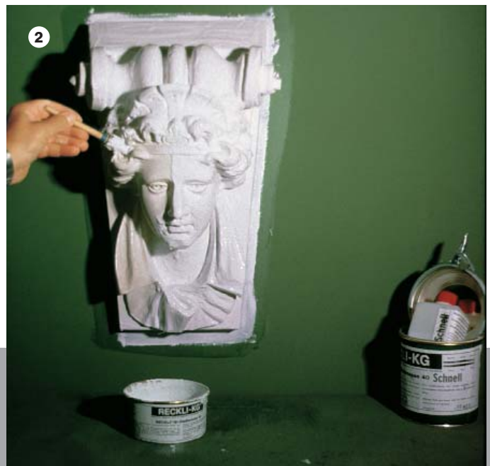
Form mit RECKLI-SI-Abformpaste HR-N bestreichen ohne Verdicker Paint mould with RECKLI-SI-Mould Paste HR-N without Thickener Couche d'impression, Pâte d'estampage RECKLI SI HR-N sans Additif thixotropant
