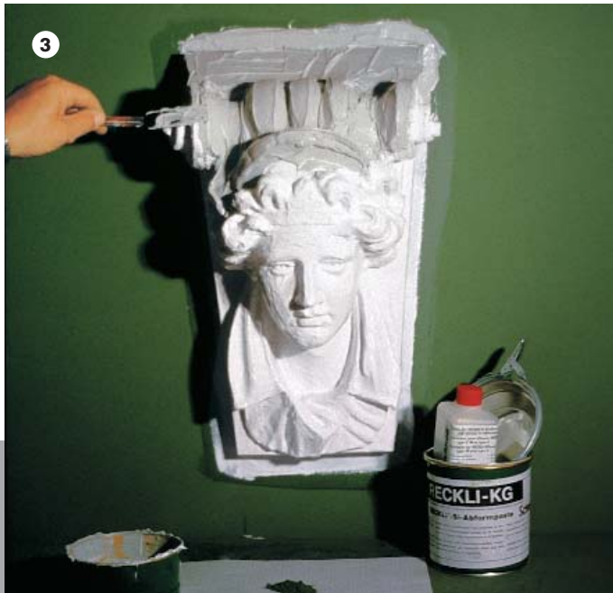
3 Erste Spachtelung mit pigmentierter Reckli-Si-Abformpaste First application of pigmented RECKLI Si Paste with smoothing trowel Première couche d'estampage, Silicone RECKLI avec incorporation de pigments
